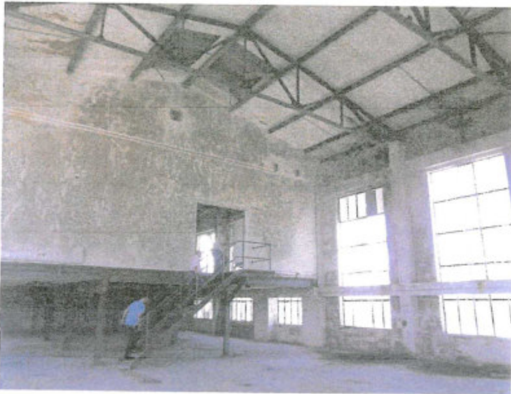
Oberstes Geschoss + Dach Hallenteil (6)
