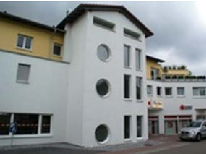
Neubau des Einzelhandels- und Dienstleistungszentrums
