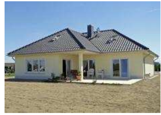
Beispiel für ein eingeschossiges, barrierefreies Gebäude
