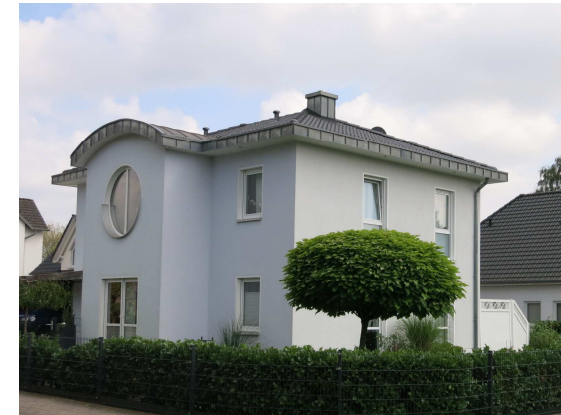
Neubau an der Schilfstraße, Hessisch Oldendorf
