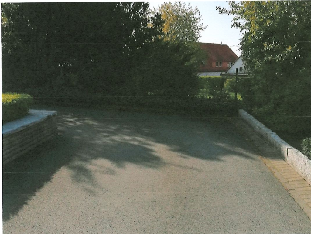
Hangstraße, Verbindung zur Fischbecker Straße
